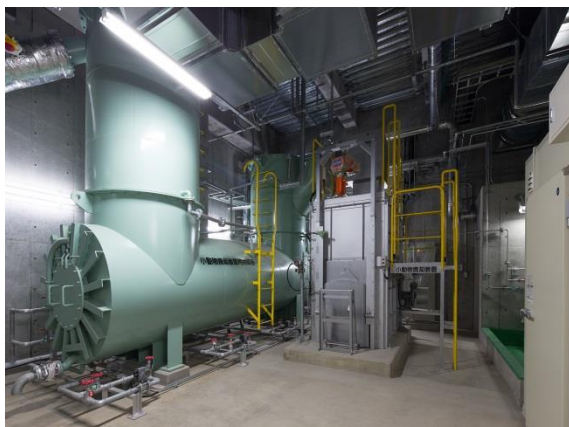
小動物焼却炉（35kg/h バッチ式）
