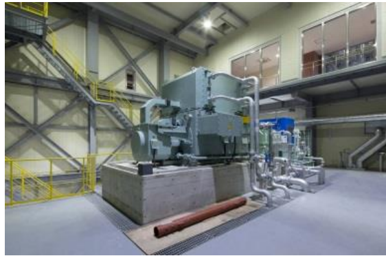
蒸気タービン発電機 (7,700kw)
