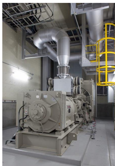
ディーゼル発電機（1,600kVA）
